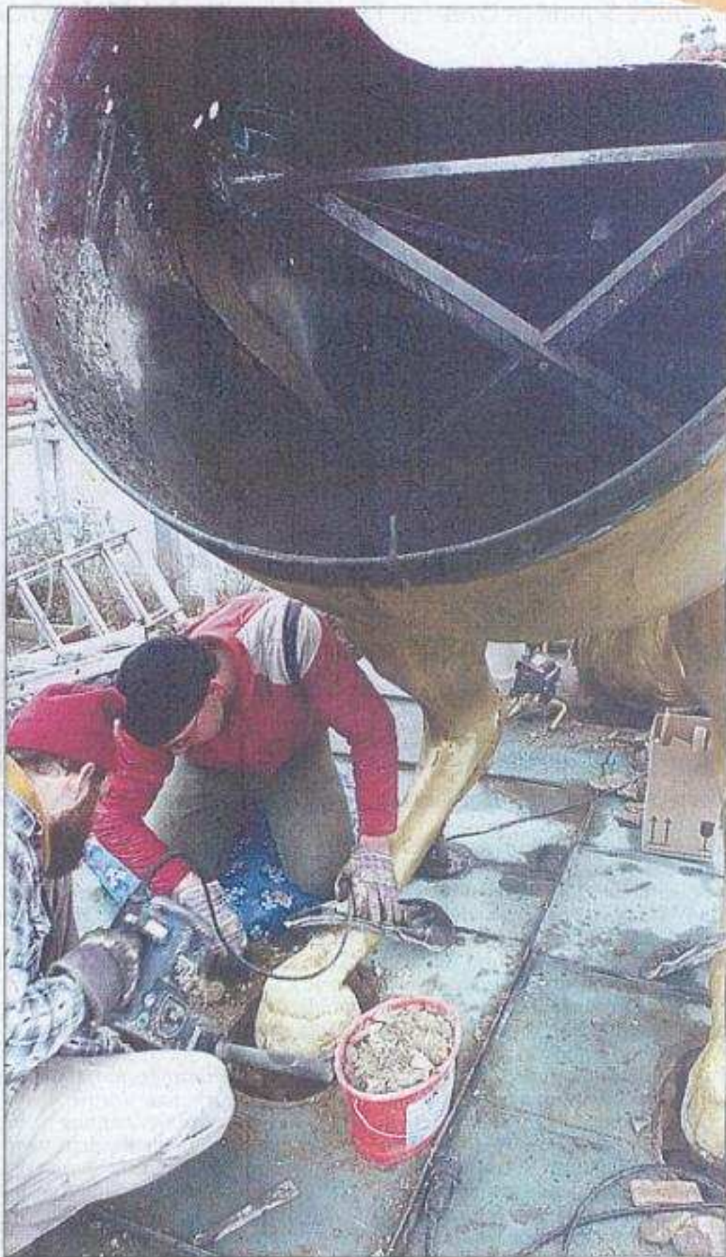
HINTERTEIL: Die eisernen Verstrebungen im Innern müssen komplett erneuert werden. Der getriebene Kupferkörper bleibt erhalten. Fotos: SZ/Jürgen Lösel
