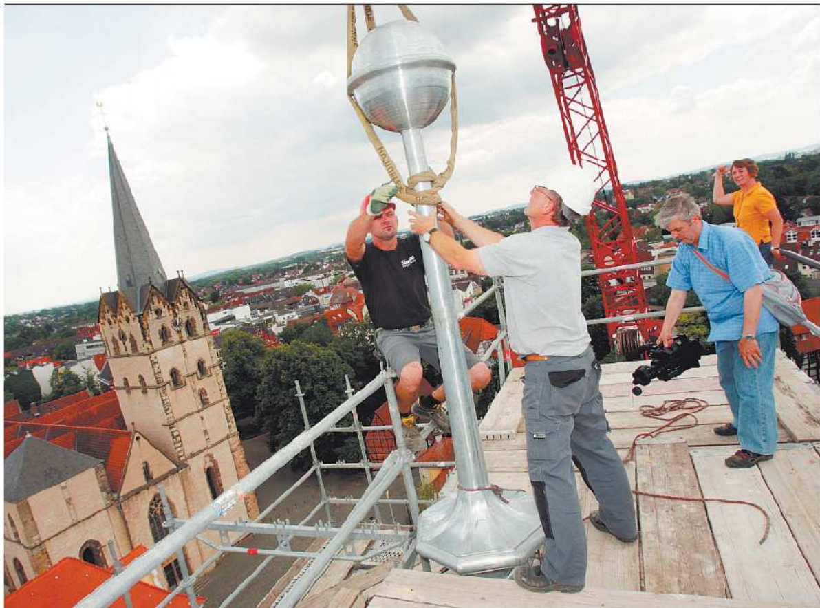
Millimeterarbeit in 47 Metern Höhe: Ralf Israel und Evgeney Möhser | Rathaus. Mit einem Baukran wurde der 75 Kilogramm schwere von der Dresdner Spezialfirma installieren die neue Spitze auf dem Kaiserstiel nach oben gehievt. Fotos: Moritz Winde
