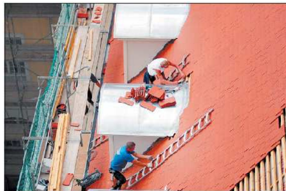
Noch haben die Dachdecker auf dem Rathaus alle Hände voll zu tun. Im Herbst sollen die Arbeiten jedoch abgeschlossen sein.
