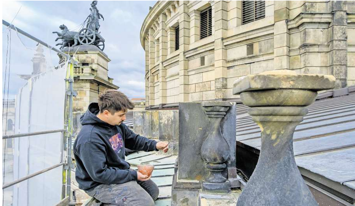
Die Dachbalustrade auf der Elbseite der Semperoper wird restauriert. Steinmetz-Lehrling Justus Birke schließt mit seiner Lanzette und Mörtel gerade eine offene Fuge. Bis November dieses Jahres sollen alle Arbeiten abgeschlossen werden.
