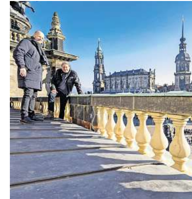
SIB-Sachgebietsleiter Knut Börner (l.) und Bauleiter Wolfram Hasert begutachten im Dezember 2025 die restaurierte Dach-Balustrade auf der Zwingerseite der Semperoper.
